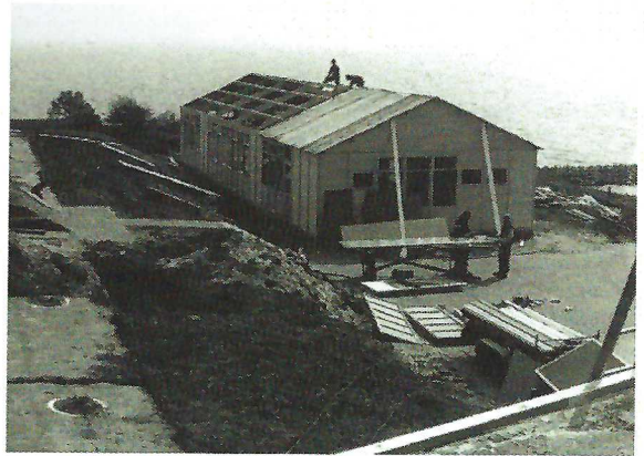
Bouw ontvangstruimte in 1991
